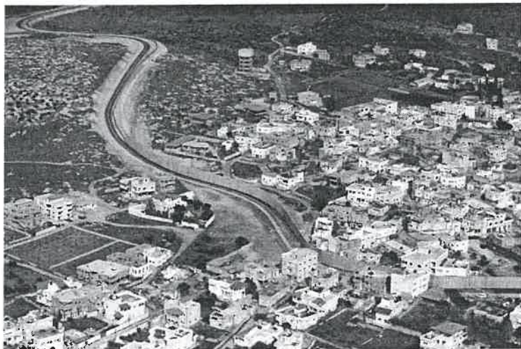
بخشی از ساخت دیوار حائل
