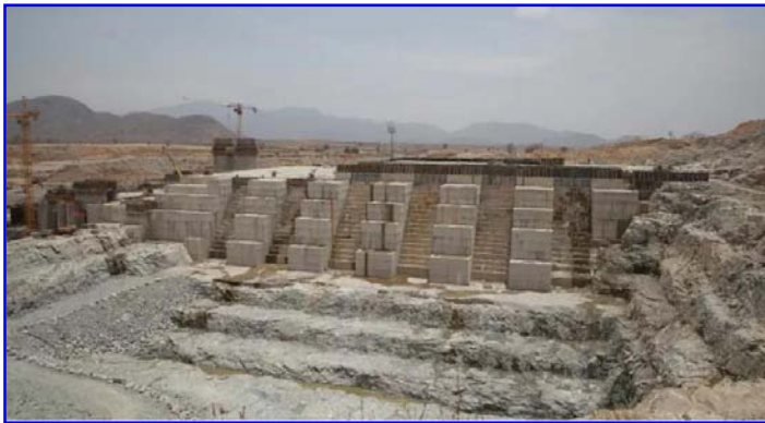
أعمال البناء في سد النهضة
